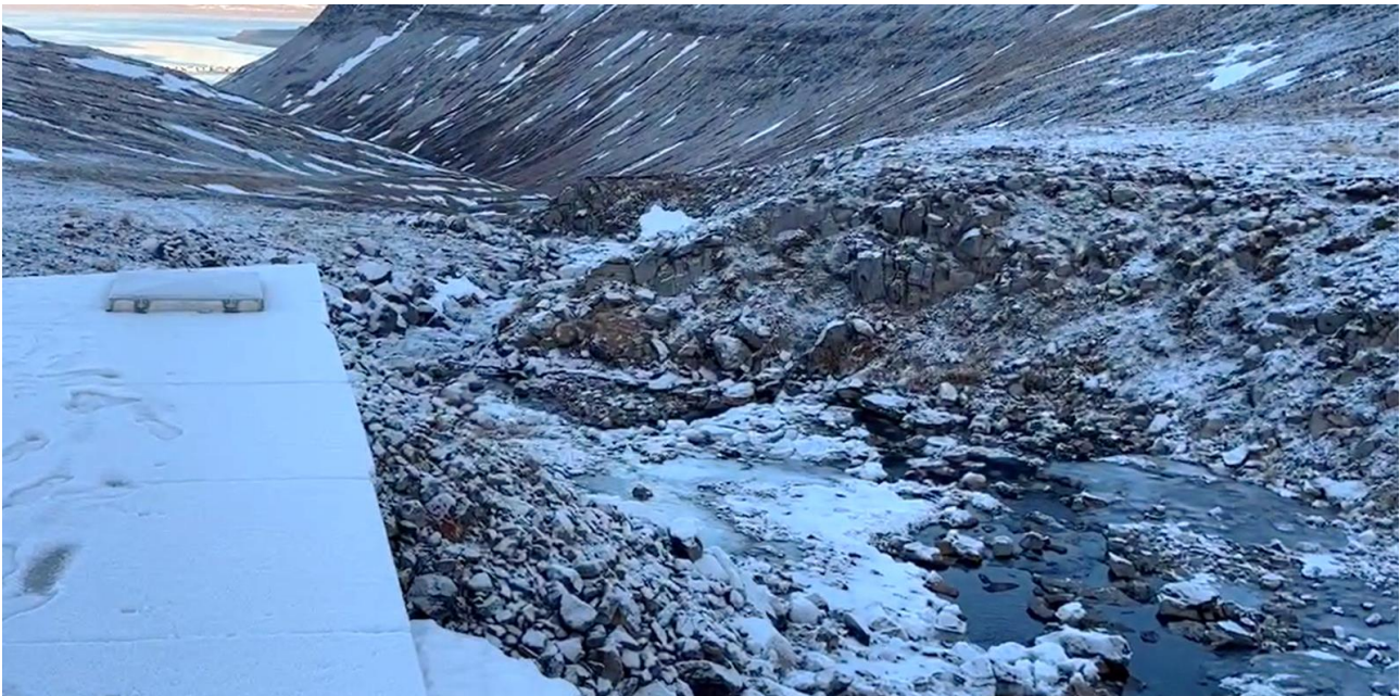
MYND 2 Farvegurinn strax neðan stíflu í frosti 1. nóvember 2023 þegar virkjunin tekur allt rennsli. Alltaf seitar eitthvað fram hjá coanda inntakinu og lindir sjá til þess að farvegurinn þornar aldrei alveg. Farvegurinn er mjög brattur og grýttur næst stíflu. Myndin er skjákot úr myndbandi. Sjá má stíflu og inntak á sama tíma á mynd 10 seinna í skjalinu.
